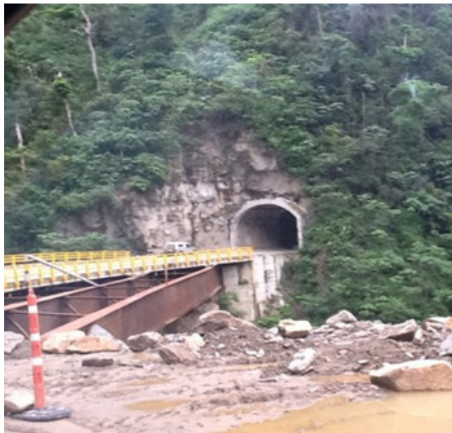
Puente la honda, tunel 3 estructura metalica construida con el diseño inicial
