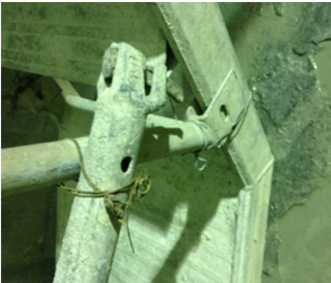
Andamios ensamblados con alambres o varillas
