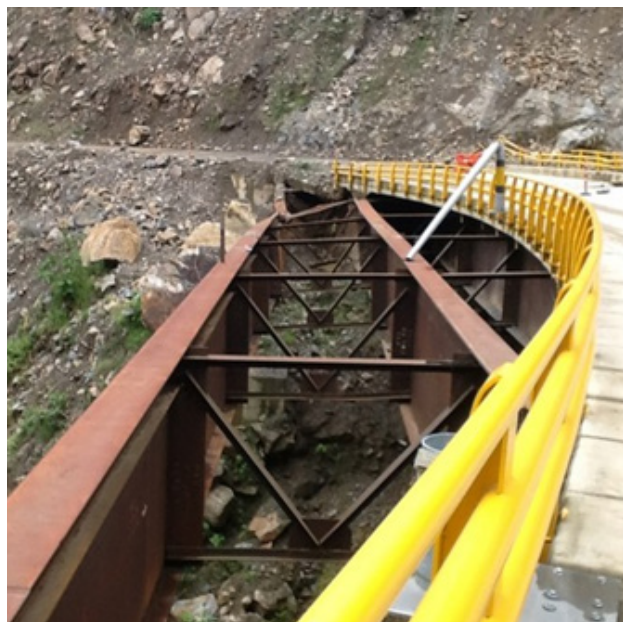
Puente la honda, tunel 3 k18+217 estructura metalica construida con el diseño inicial
